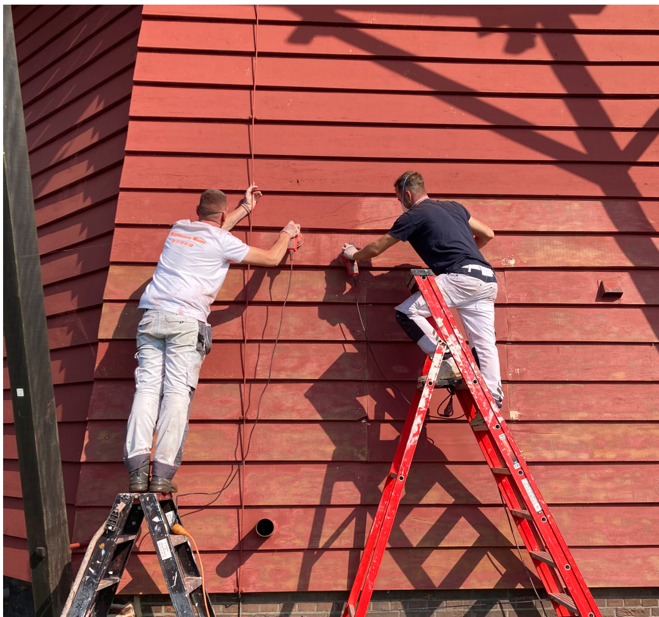
SCHILDERSWERKZAAMHEDEN BIJ MOLEN DE HOOP IN DOKKUM
