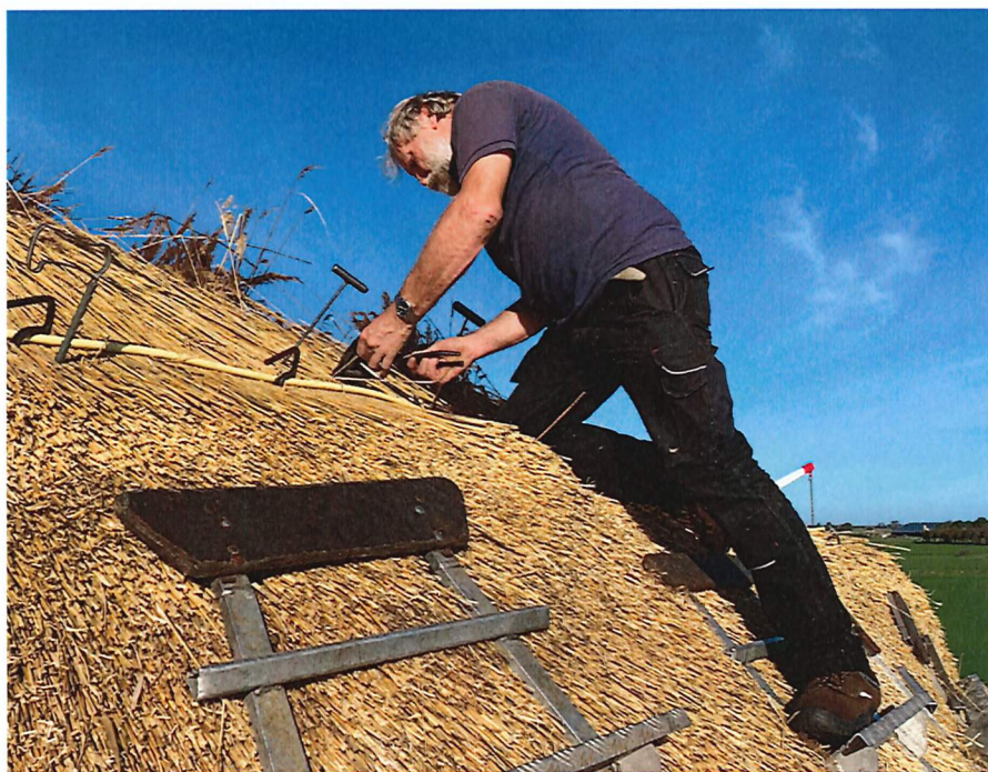
RIETDEKKER KLEINJAN UIT DEN HAM AAN HET WERK OP DE KAP VAN DE HANTUMERMOLEN
